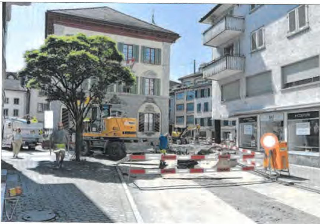
Bereits im Gange: die Leitungsarbeiten rund um den Lachner Rathausplatz.
