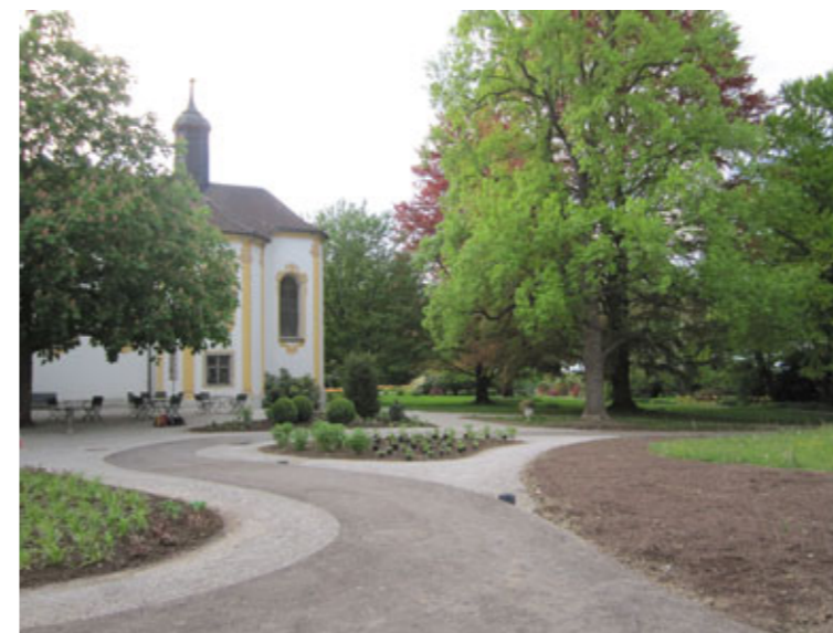
Restaurierter und weitergestalteter Hof kurz vor Fertigstellung
